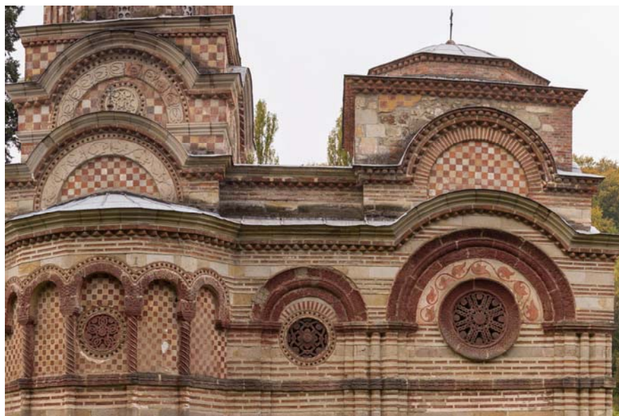
Slika 5 - Kalenić, gornje zone severne fasade objekta sa prikazom pozicija različitih tipova arhivolti, foto Svetozar Petrović
